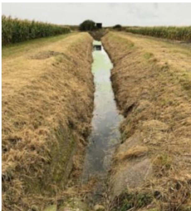
Figur 1: Billede af den eksisterende pumpegrøft set fra østlig retning.
